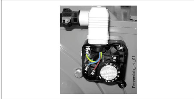
I pressostati di controllo della pressione del gas (minima e massima) hanno lo scopo di impedire il funzionamento del bruciatore quando la pressione del gas non risulta compresa nei valori previsti.
